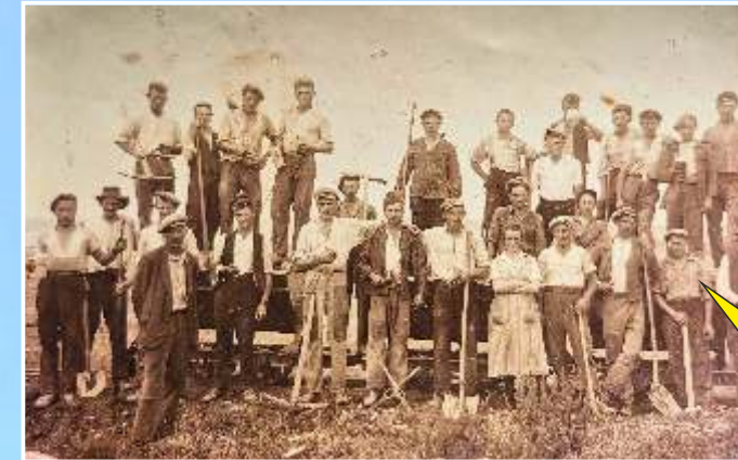
Baustelle der heutigen A 62 mit Lorenbahn, 1940
