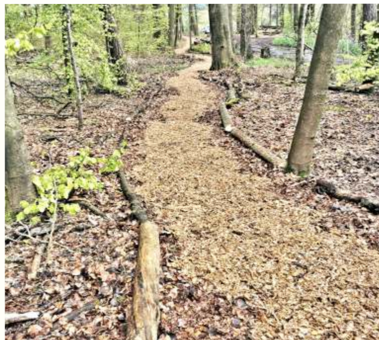
Und hier der unmittelbar daneben neu angelegte Waldpfad: Holzhackschnitzel sorgen für einen trockenen und sicheren Untergrund.
