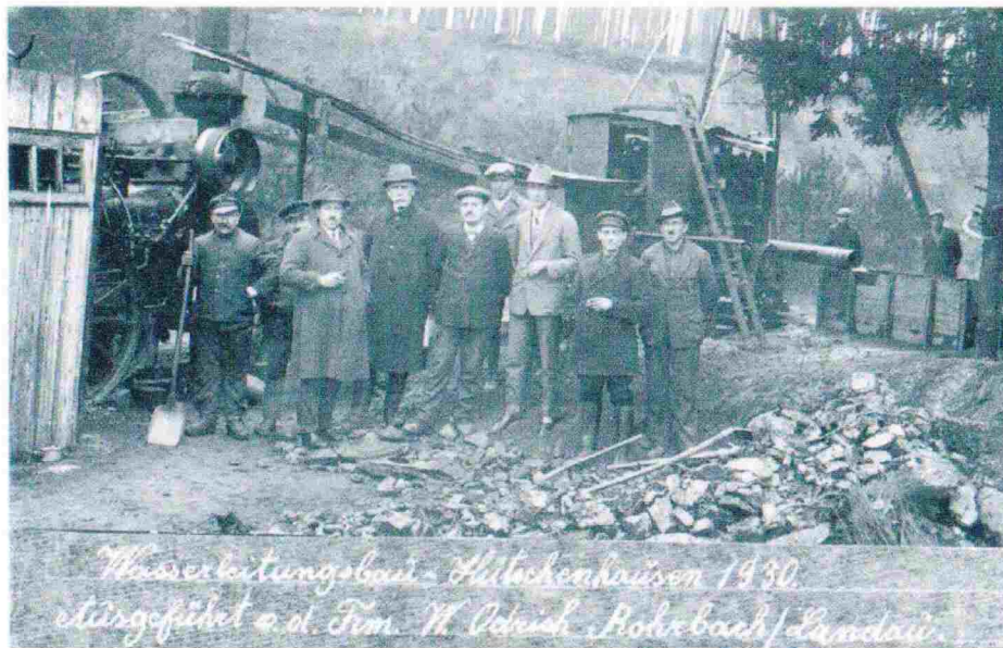
1. Spatenstich zum Wasserleitungsbau in Hütchenhausen 1930 An dieser Stelle steht heute das Wasserhäuschen
