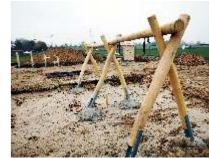
Der Spielplatz ist bis zu seiner Fertigstellung noch eingezäunt
