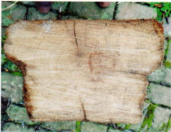
Querschnitt eines Eichenbalkens der Decke über dem Erdgeschoss
