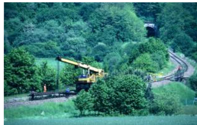
Gleisabbau am 1. Juni 1987 bei Elschbach. Der Haltepunkt „Elschbach Ort“ war erst Anfang der 60er Jahre hier eingerichtet worden. Foto: Hans-Joachim Emich
