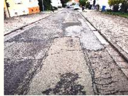
Die Waldstraße und die Friedhofstraße werden als Erste ausgebaut.
