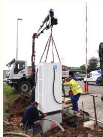
Mit schwerem Gerät haben die Pfalzwerke die Ladesäule aufgestellt...
